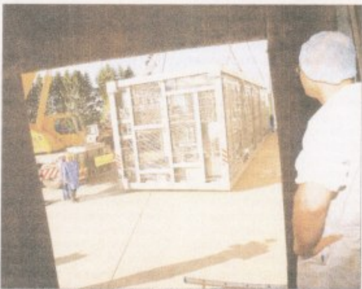
Les pièces maîtresses de la nouvelle usine ont été acheminées par convoi exceptionnel sur le site de Bastogne.
